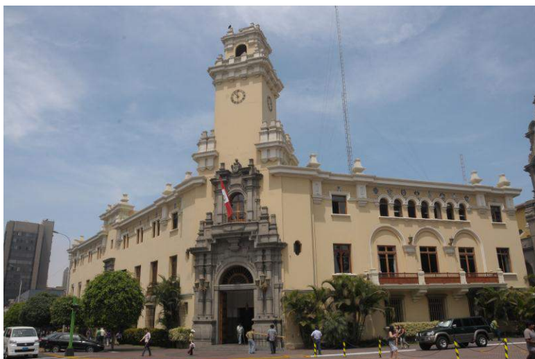
Palacio Municipal de Miraflores Fuente: Municipalidad de Miraflores
